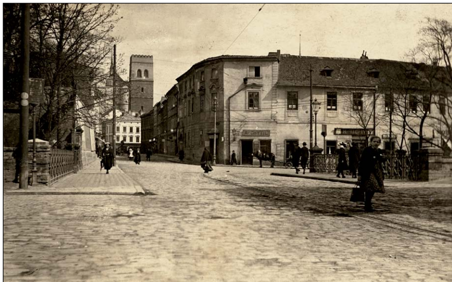
Obr. 13. Böhmer Gasse – Česká ulice (nyní 8. května), vpravo před mostem přes Mlýnský náhon nárožní dům čp. 447/2, 30, zbouraný v roce 1912 a nahrazený v následujícím roce secesní novostavbou kina Edison, vlevo zbytek pevnostního valu. Nedatovaná fotografie, patrně z let 1900–1910. Státní okresní archiv v Olomouci, fond M 8-34, Sběrka obrazového a fotografického materiálu, inv. č. 3055, sign. XXX1/097.
