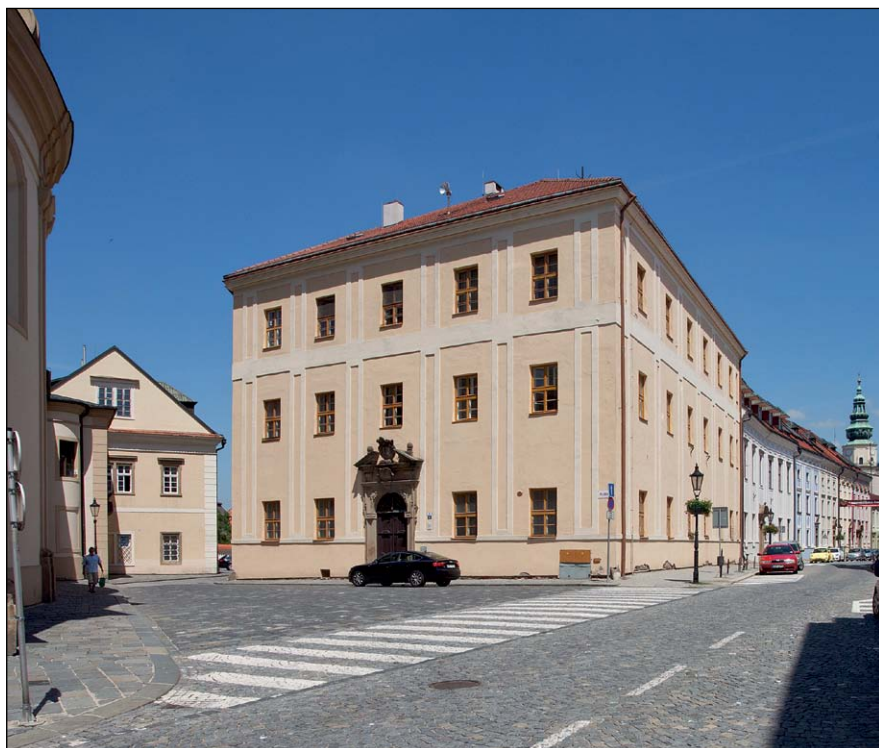
Obr. 5. Pohled na bývalé Německé gymnázium v Kroměříži a za ním navazující zpěvácký seminář. Foto: Zdeněk Sodoma, MUO.
