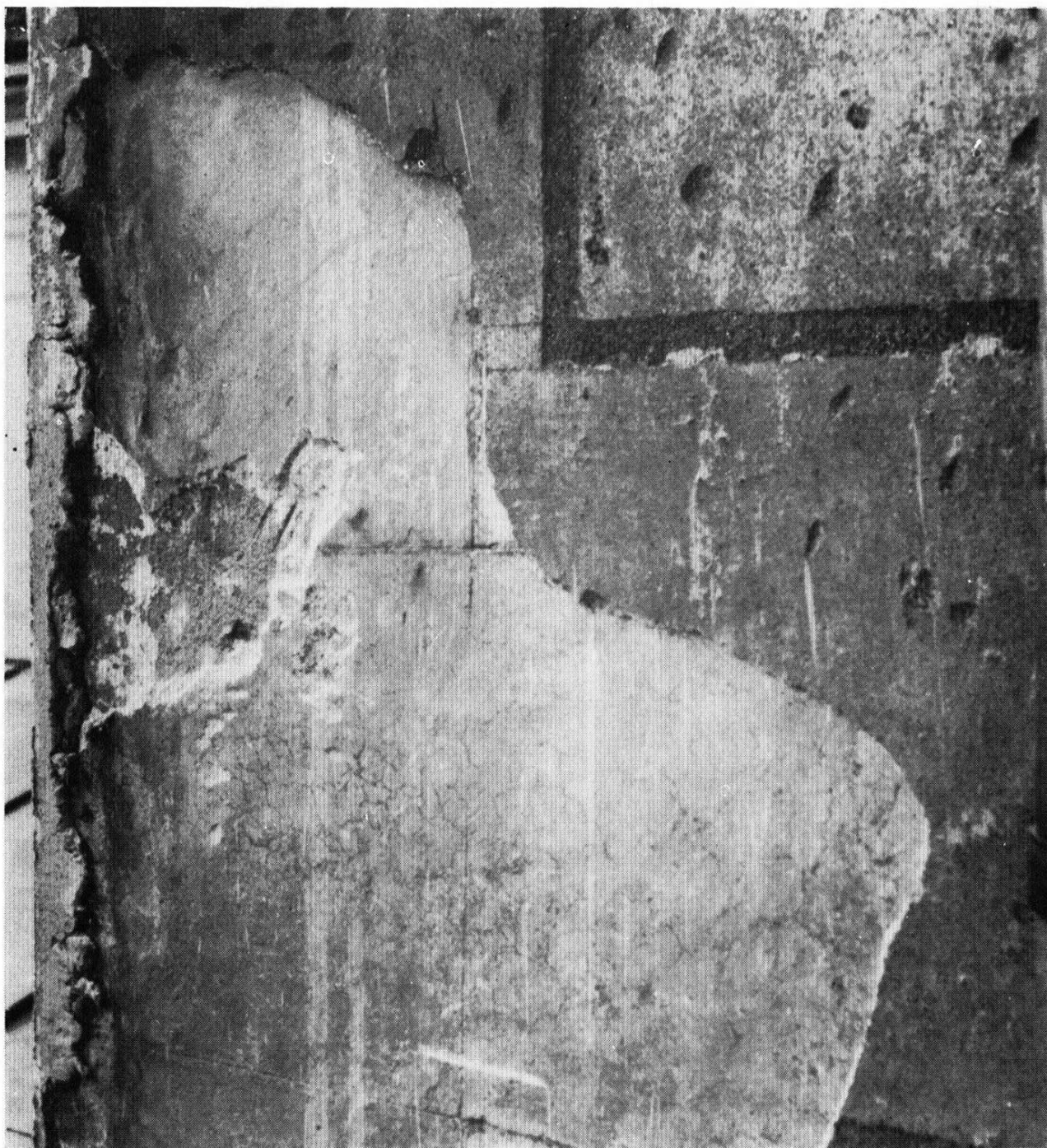
Olomouc, arcibiskupská residence. Gotická a renesanční omítka na fasádě zahradního rizalitu. Stav r. 1972. Snímek I. Hlobil.
