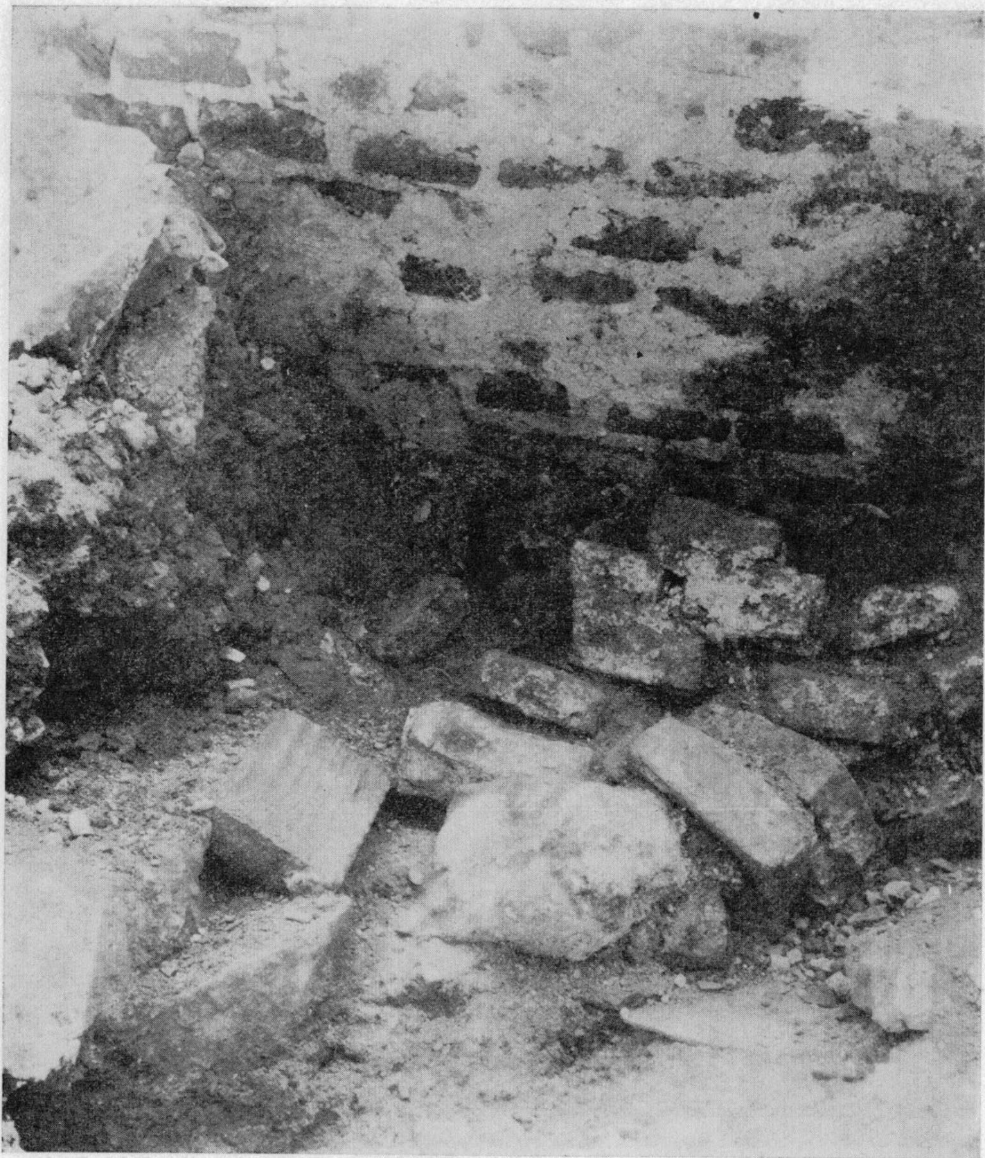
Dolany, Kartouzka. Destrukce klenby v místnosti O. Rubní strana bloku z pohledu (v horní části snímku). Stav v červenci 1973.
