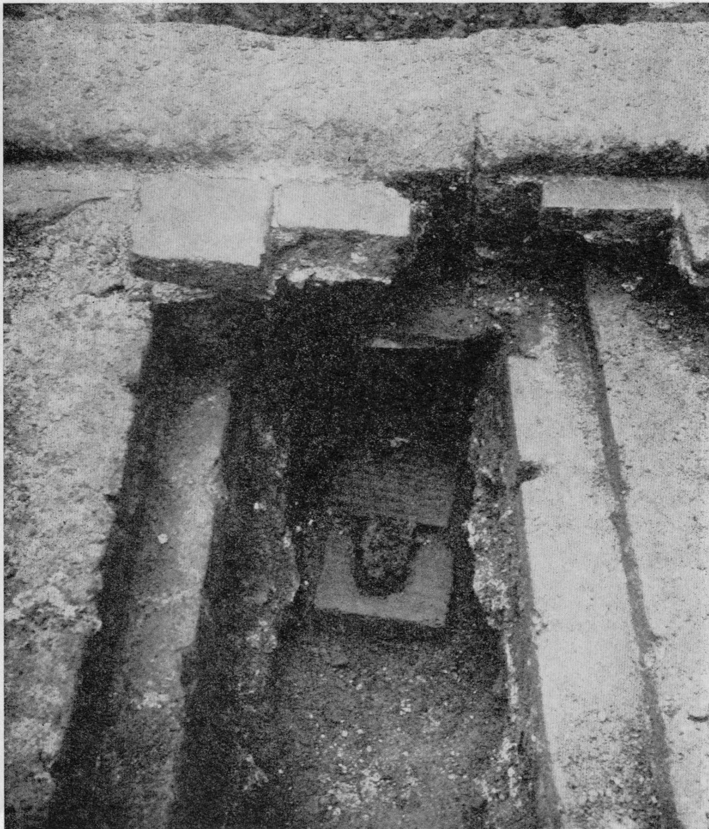
Dolany, Kartouzka. Zbytky vodovodního potrubí, uložené na cihlách severně od prahu portálu. Stav v červenci 1973.
