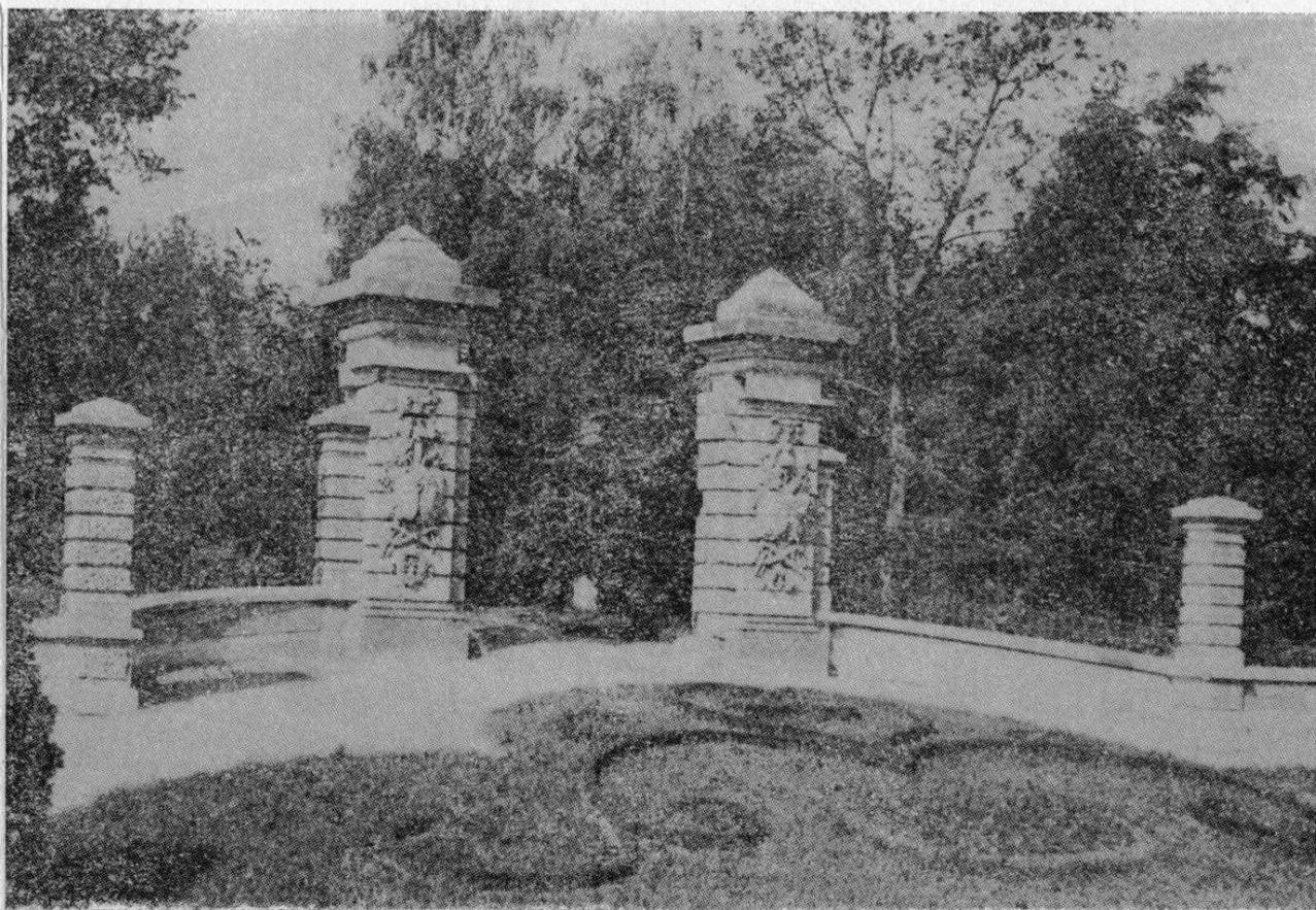
Předbrání Terežské brány z ravelinu přeložené r. 1898 do bočního vchodu parku. Stav r. 1931.
