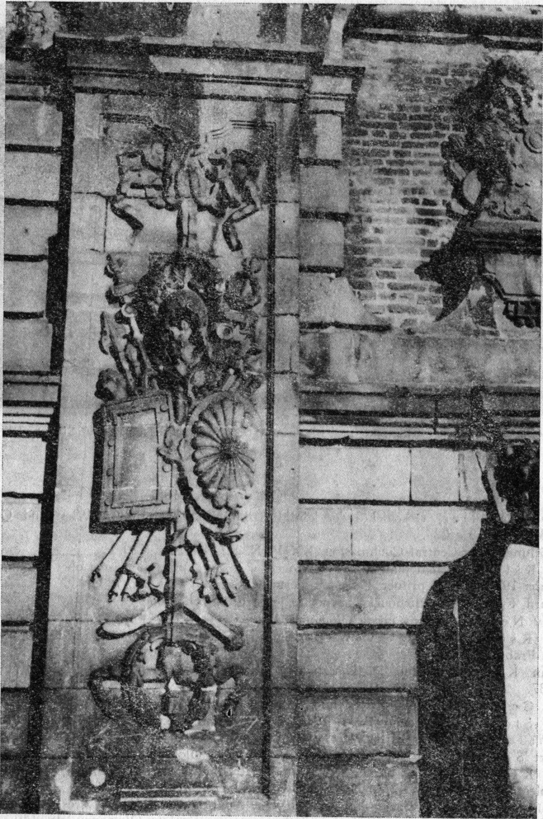
Reliéfni výzdoba pilastru a detail stěny Terežské brány. Stav r. 1951.
