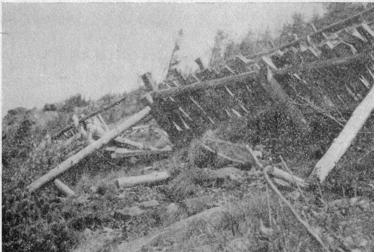
Obr. 3 a 4. Strž č. 6., která vznikla v roce 1921. Pohled na část nad turistickou cestou, kde jsou agrotechnická opatření stále neúčinná
