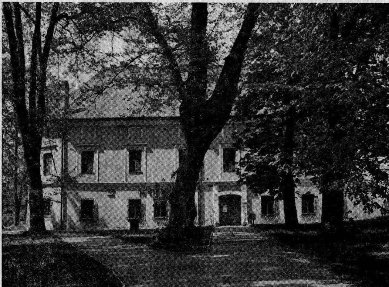
Litovel, okr. Olomouc: Bývalý hostinec na Střelnici (nyní budova KVMO), Dr. J. Smyčky 199, místo prvního veřejného vystoupení komunistů Litovelska v souvislosti s 1. májem 1927.
