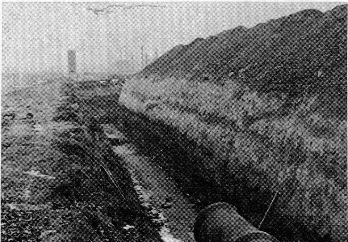
obr. 4 Horní Heršpice, rýha pro trubní vedení, odkrývající sprašovou sérii v nadloží říčních štěrkopísků. Foto J. K a r á s e k, prosinec 1973.
