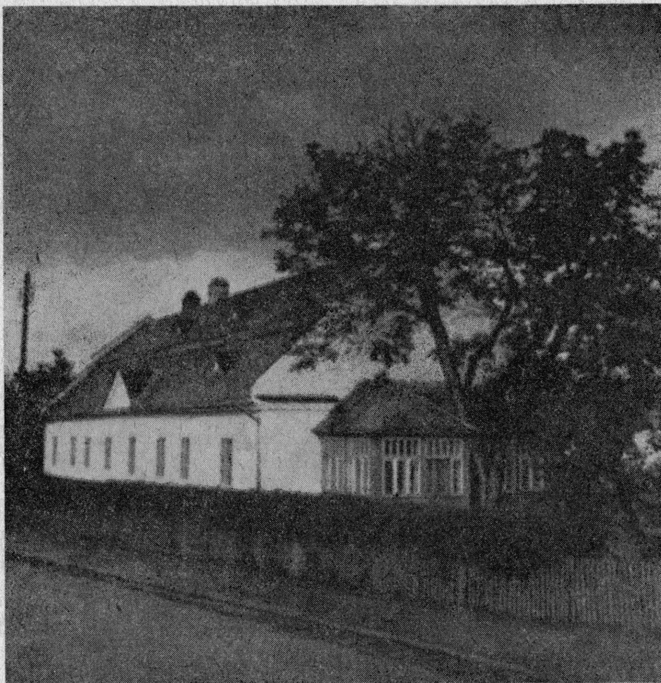
Hlavní budova poštovní a přepřahací stanice ve Velkém Újezdě, 1789-91, snímek ze 40. let 20. stol., archiv E. Richterové
