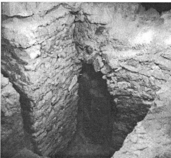
Abb. 5. Fundament des barocken Pfeilers 7 und unterirdische Wölbung zwischen den Pfeilern A und B der Lettnerwand. Blick aus dem Chor von Nordosten.
