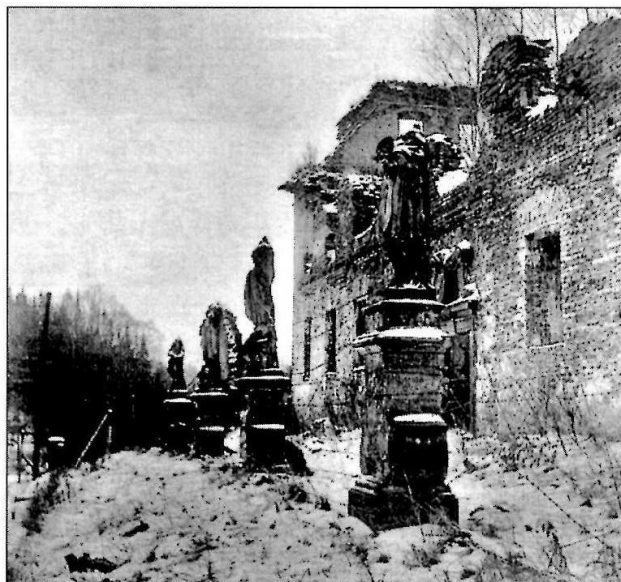
Sochy před hlavním průčelím a část hlavního průčelí kláštera, prosinec 1964. Foto archiv Národního památkového ústavu Ostrava.
