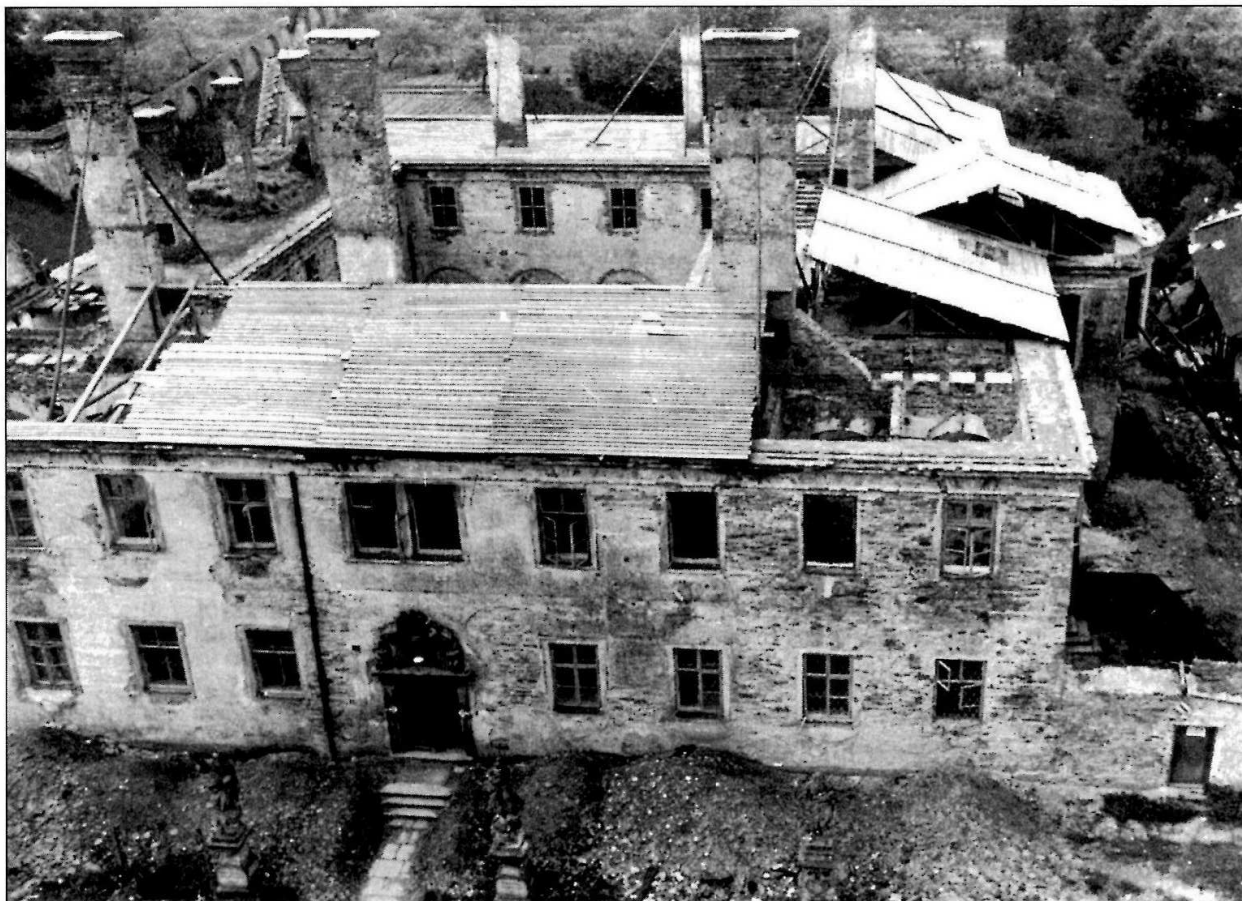
Pohled na budova kláštera z věže kostela sv. Anny a sv. Jakuba Většího, stav po požáru v roce 1945. Foto archiv Národního památkového ústavu Brno.
