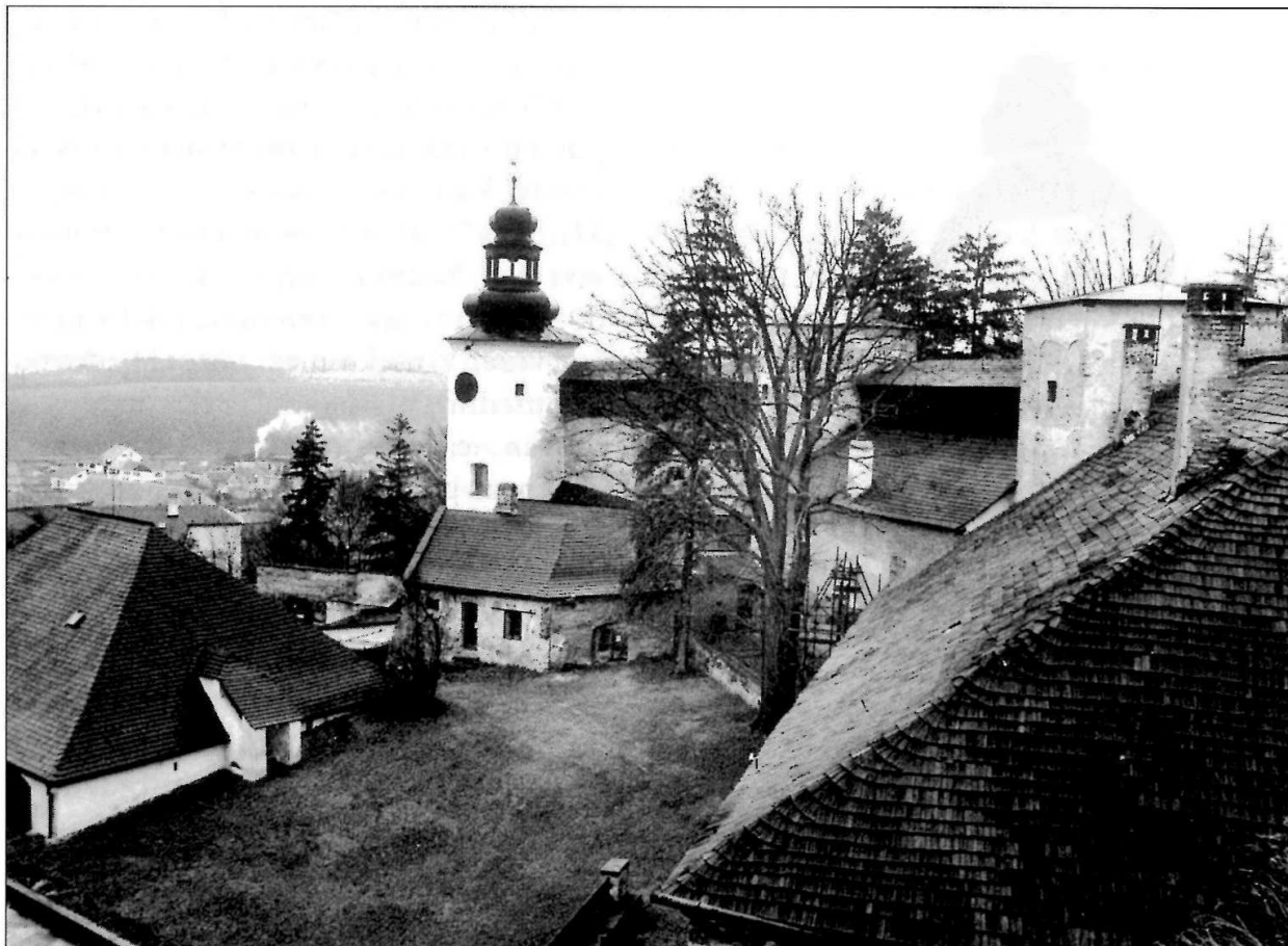
Pohled na nádvoří někdejšího hradu s kočárovnou, „Hladovou“ věží, budovou někdejšího Vlašimského paláce, věží „Vlašimkou“, tzv. Boskovickým palácem a věží s polygonální vnitřní částí, vpravo dole střecha budovy tzv. staré školy. Foto Markéta Ondrušková.
