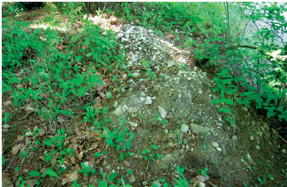
Obr. 2. Výkliz vápenců z původní silnice do Zikmundova, foto P. Novotný, květen 2011
