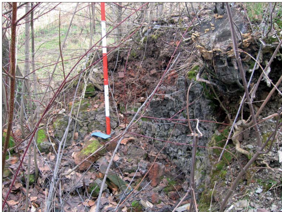
Obr. 10. Kadeřín, detail šamotové vyzdívky tzv. Žákovy pece náležející k č. p. 8 v intravilánu obce, pohled od jihu, 2007. Foto: Karel Faltýnek.
