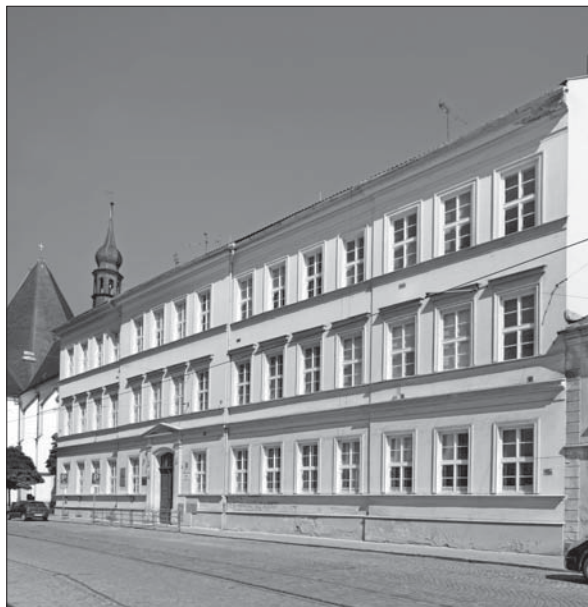
Obr. 2. Současný pohled na bývalou budovu Matice školské v ulici na Bělidle (dnes Sokolská 19). Foto: Pavel Rozsívál.
