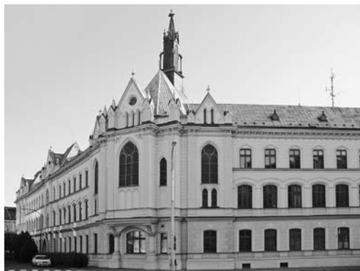
Obr. 1. Pohled na část budovy Pöttingea, stav před poslední opravou střechy. Foto: autor.
