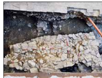
Obr. 5. Zbytky kamenné severní zdi a severovýchodního nároží tzv. Juliánské věže, vpravo patrné torzo opěráku, celkový pohled do sond S21/17 a S26/17. Foto: T. Zlámal, Národní památkový ústav, územní odborné pracoviště v Olomouci.
