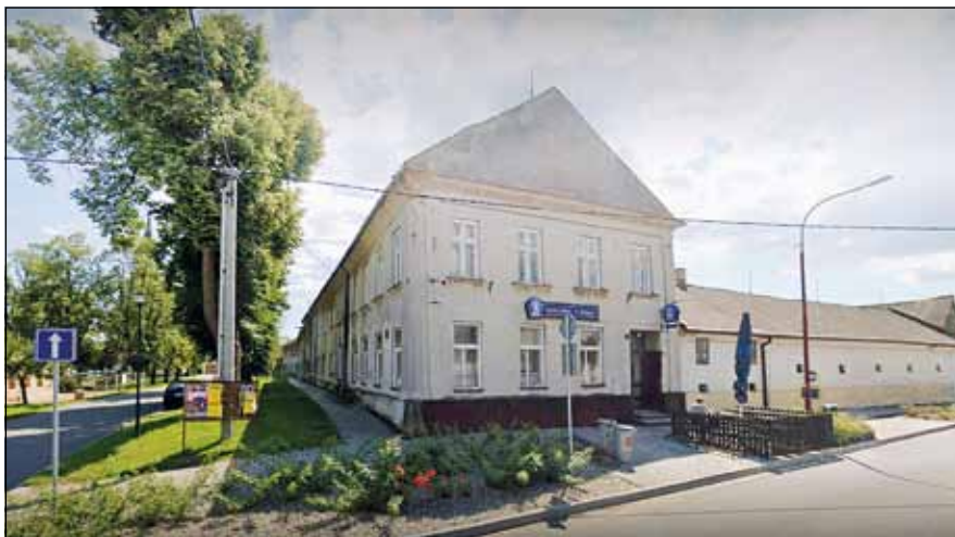
Obr. 4. Přestavěný dům ve Smržicích u Prostějova, sídlo hlavního štábu pruského krále Fridricha II. během obléhání Olomouce v roce 1758, na nároží ulic Prostějovská a Zákostelí, Prostějovská č. 545, s restaurací U Býka. Zdroj: http://google.com/maps/ .
